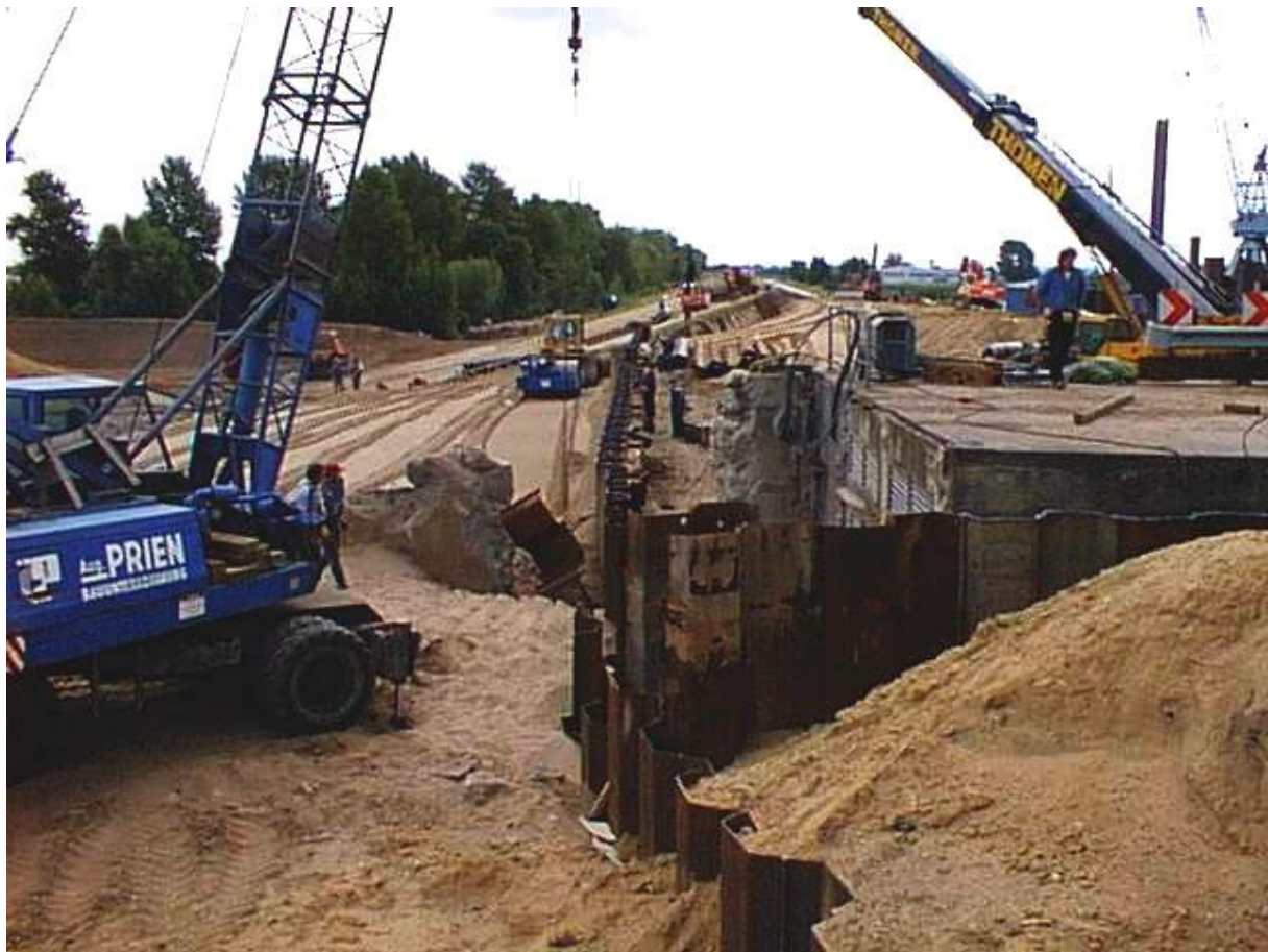
Abbruch des alten Widerlagers mit Spundwänden Baugrubenverbau
